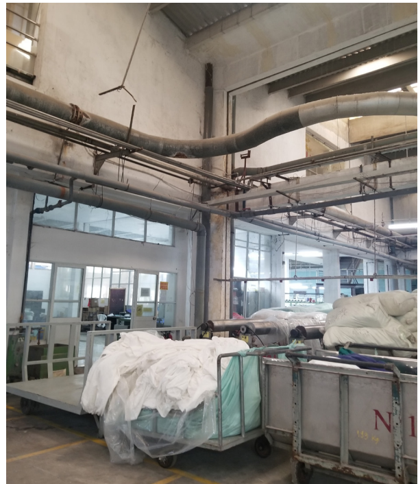
Hình 33. Hệ thống đường ống dẫn nước mưa của xưởng nhuộm vào mương thoát nước mưa
