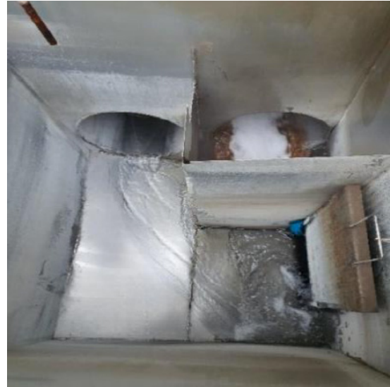
Hình 18. Chia dòng xả thải từ quy trình nhuộm ở nhà máy khác
